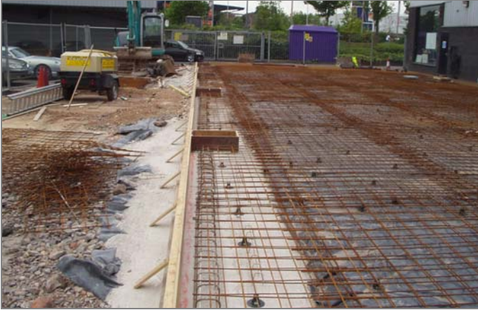
PRIOR TO CONCRETE POUR
